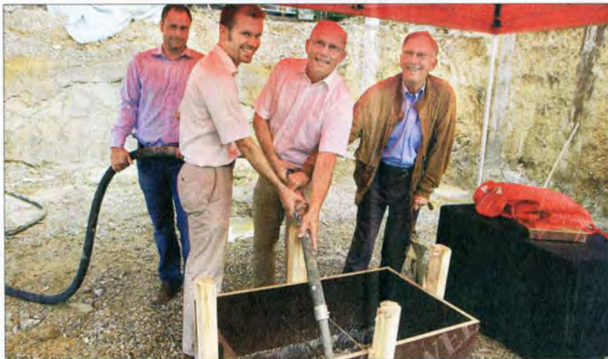
Bei der Grundsteinlegung (von links): Lars Bargmann, Christian Ante, Markus Keune und der erste Käufer, Professor Jochen Lehmann. FOTO: GALLIEN
